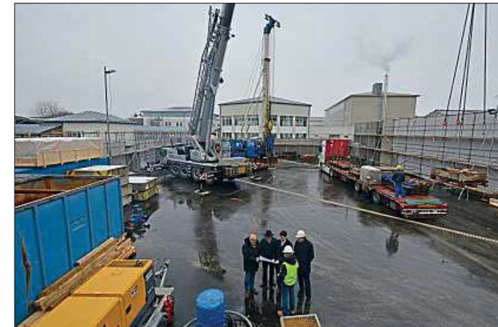
Die Vorbereitungen am Bohrfeld laufen auf Hochtouren – über die Weihnachtsfeiertage bis nach Heilige Drei Könige ruht die Baustelle allerdings.
