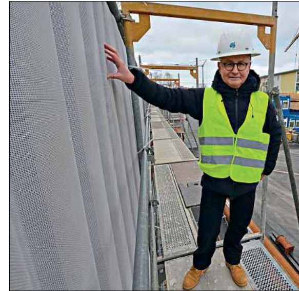
An der Nord- und Westseite des Vorplatzes der Bohrung sind die Lärmschutzwände bereits sechs Meter hoch, nun werden sie auch im Osten von drei auf sechs Meter hochgezogen, erklärt Diplom-Geologe Manfred Piewak. – Fotos: Jörg Schlegel
