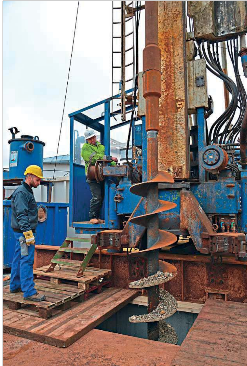
Auf 250 Meter ist man bislang im Zuge der Ersatzbohrung der Therme ins Erdreich vorgestoßen. Momentan wird die Verrohrung einzementiert, ab Montag soll weiter gebohrt werden.
