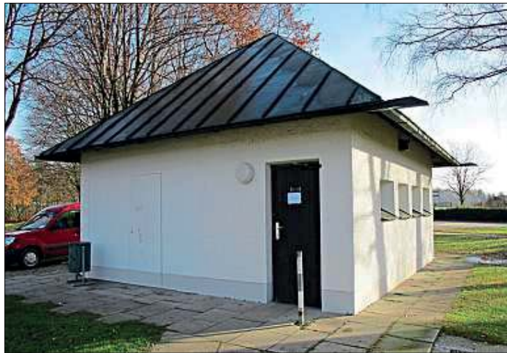
Für mehrere Wochen gesperrt ist die Toilettenanlage nach den Zerstörungen durch Vandalen. – Fotos: Gemeinde
