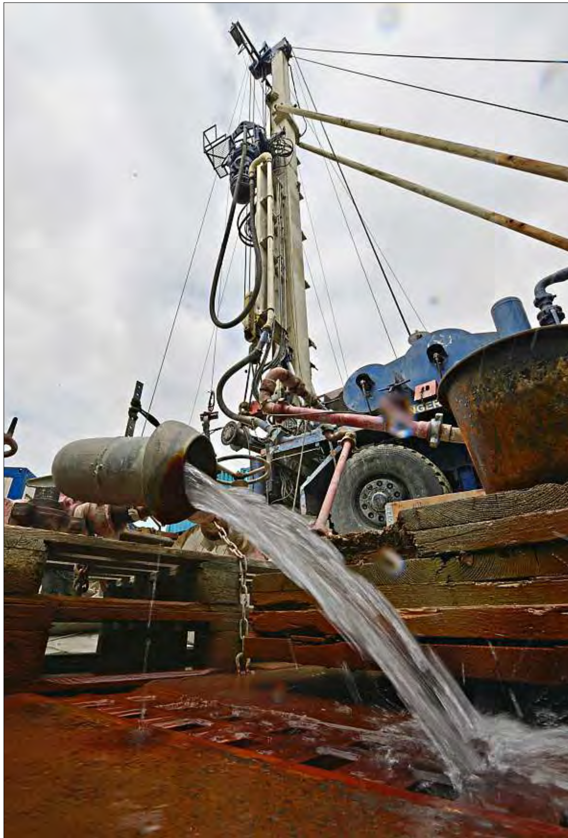
Der erste Bohrversuch in der Therme 1 förderte zwar Wasser zu Tage, jedoch es war zu wenig. Deshalb wird nun eine zweite Bohrung folgen. – Foto: Jörg Schlegel
