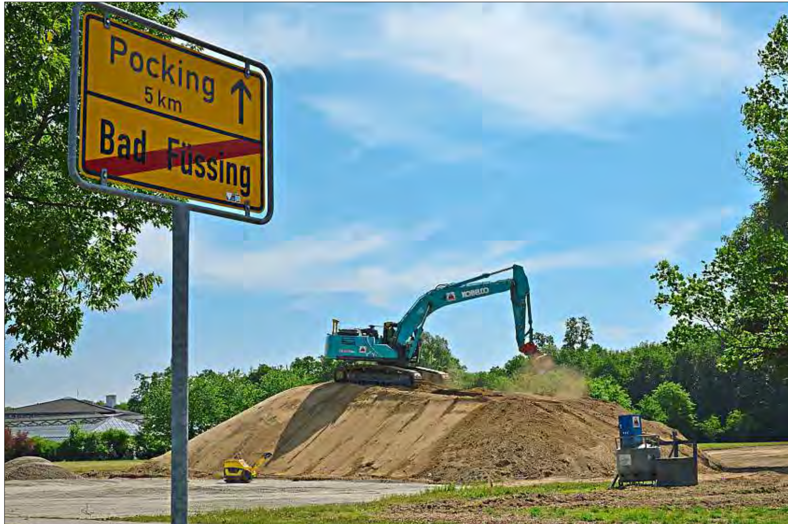
Die Tiefbauarbeiten zur Neugestaltung des Bad Füssinger Ortseingangs sind bereits angelaufen. Bei der Vergabe der Hochbauarbeiten am Kurparkeingang gab es nun Ärger im Gemeinderat – wegen der enorm gestiegenen Kosten. – Foto: Jörg Schlegel
