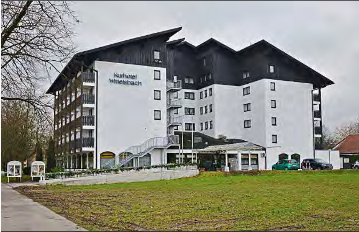
Das Hotel „Wittelsbach“ im Herzen Bad Füssings wird generalsaniert.
