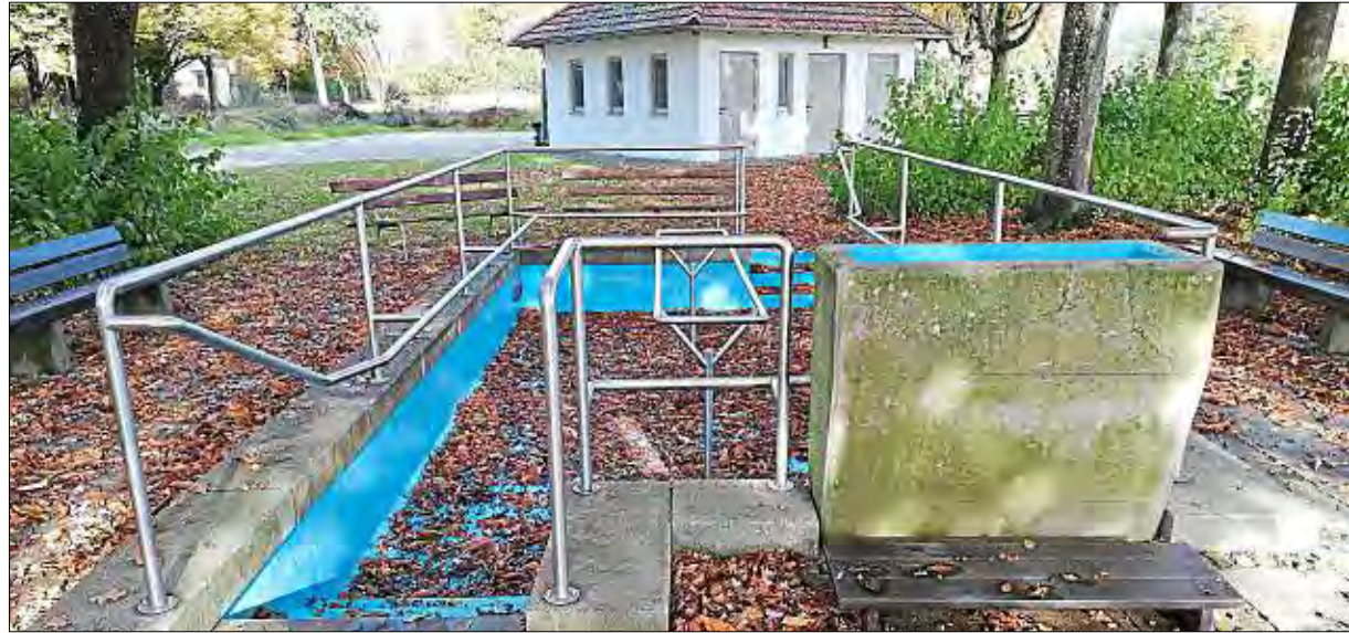
2021 soll auch die Kneippanlage bei der Kurgymnastikhalle saniert werden.
