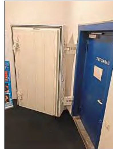
Weit mehr als Brandschutz: Die schweren Metalltüren an den Tiefgaragenzugängen zeugen vom Bunker-Ausbau.
