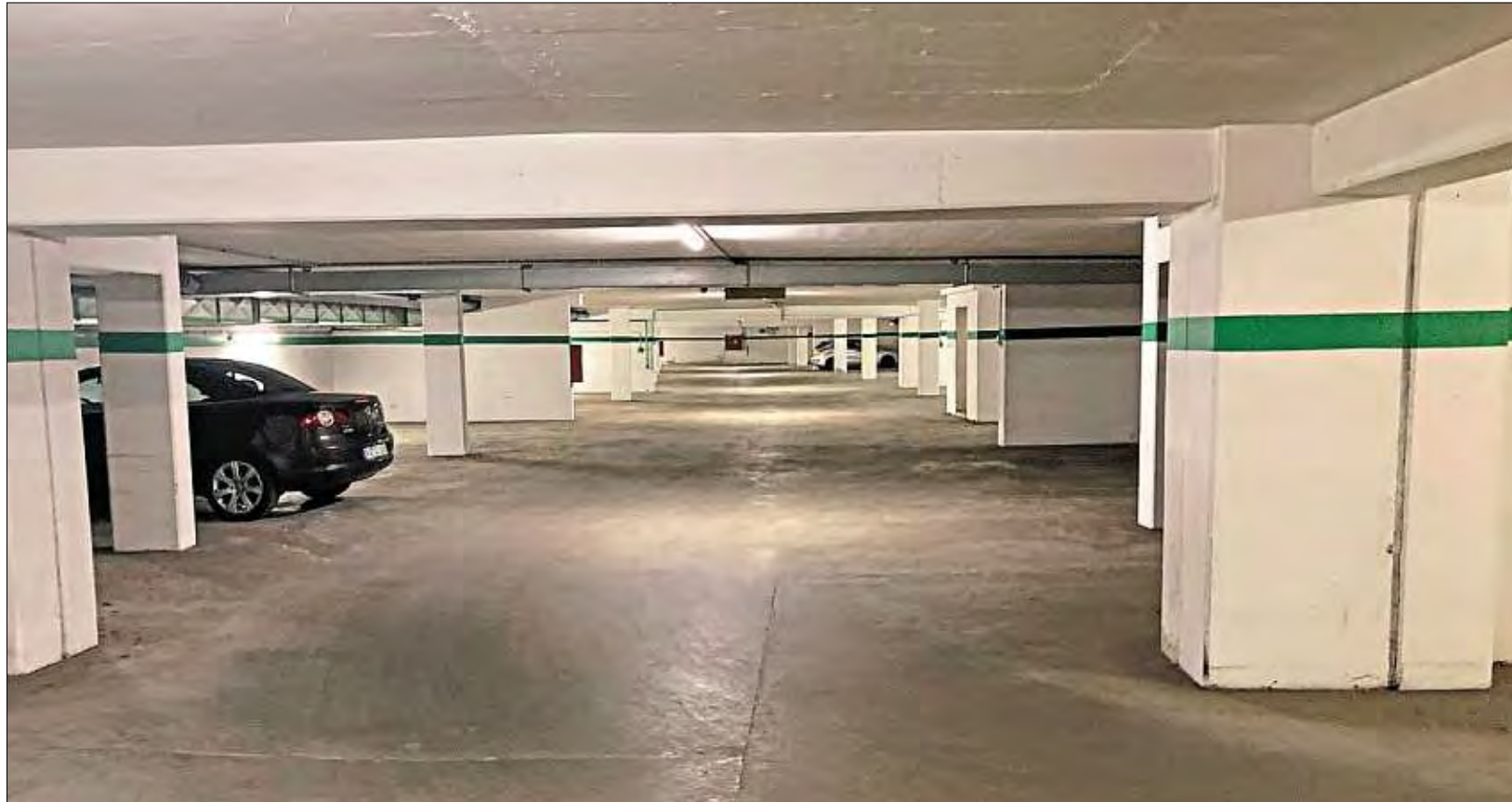
Die Rathaustiefgarage in Bad Füssing mit über 300 Stellplätzen (hier der Bereich zwischen den Aufgängen Rathaus und Kirche) wurde bei ihrem Bau in den 1980er Jahren zugleich als Schutzraum angelegt. Der soll nun ertüchtigt werden, fordert die CSU.
