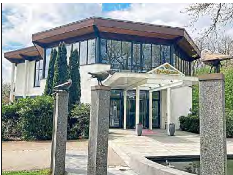
Nach 20 Jahren sind die ersten Sanierungsmaßnahmen an der Bad Füssinger Spielbank fällig.
